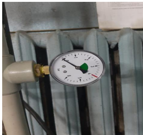
7 Сурет – осьтік манометр 6 бар G1/4
